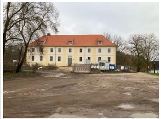
Foto 4: In Sanierung befindliches Altes Amtshaus
