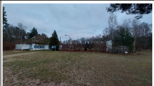
Foto 6: Autokino mit vorgelagerter Wiese
